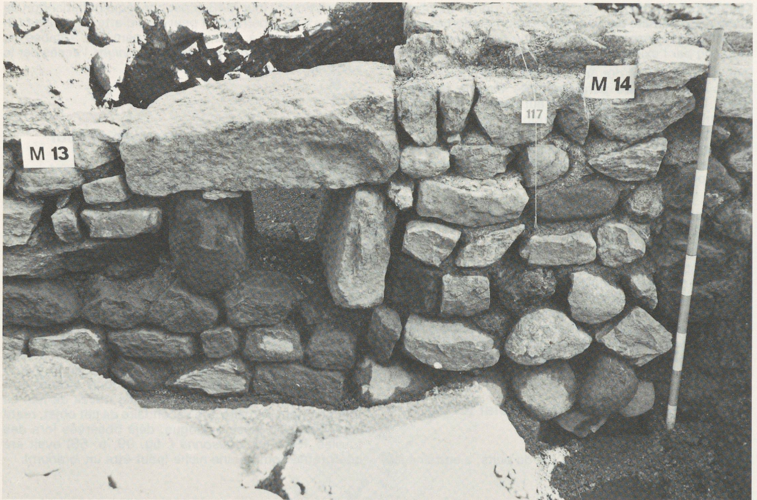
Fig. 36. Bât. ouest, cour: caniveau dans le mur M13; vue est.
