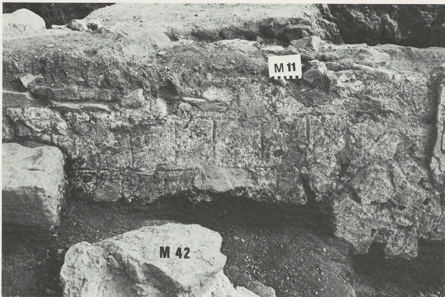
Fig. 48. Bât. ouest, cour, mur M11, vue nord: enduit de préparation.
