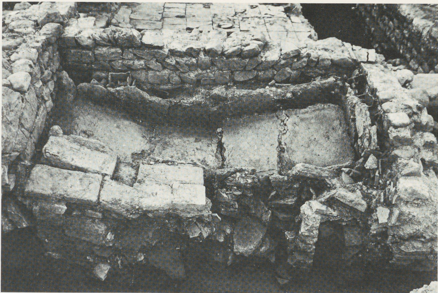
Fig. 66. Bât. ouest, local L3A : baignoire du caldarium, vue est.
