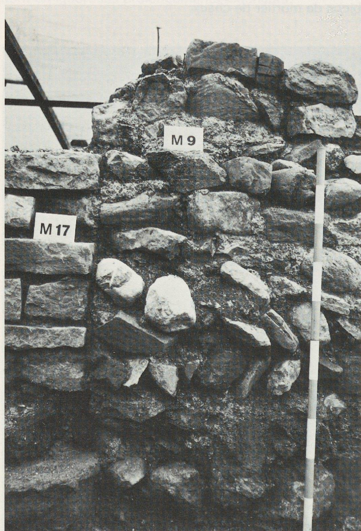
Fig. 44. Bât. ouest: détail de la jonction des murs M17 et M9 (vue est).
