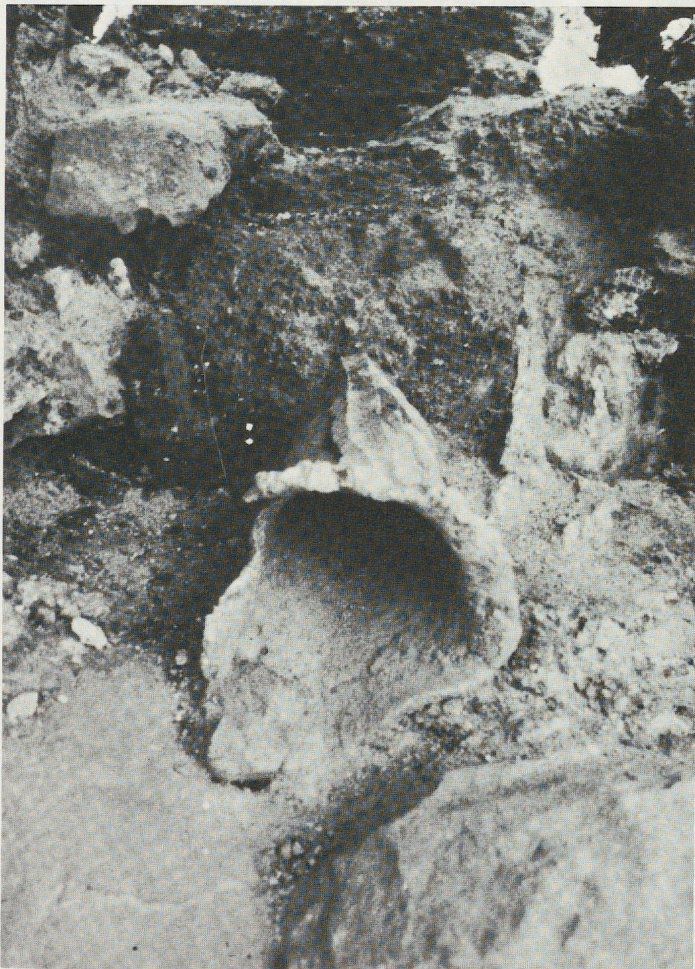
Fig. 76. Bât. ouest, local L1 : écoulement dans le mur M3, vue nord.
