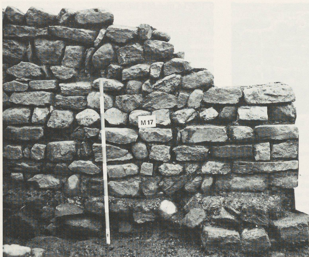
Fig. 43. Bât. ouest: vue est de l'extrémité sud du mur M17. A: ressaut de fondation; B: élévation; C: assise en chanfrein.
