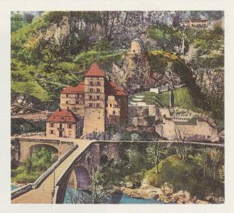
Fig. 74 La position du château vue de la rive vaudoise, à la fin du XIX<sup>e</sup> siècle. Au premier plan, la batterie avancée (W 6a) puis la batterie étagée (W 5), un mur crénelé et fossé (W 13), dominés par la tour Dufour (W 14). Carte postale, édition Heyraud, Saint-Maurice.
