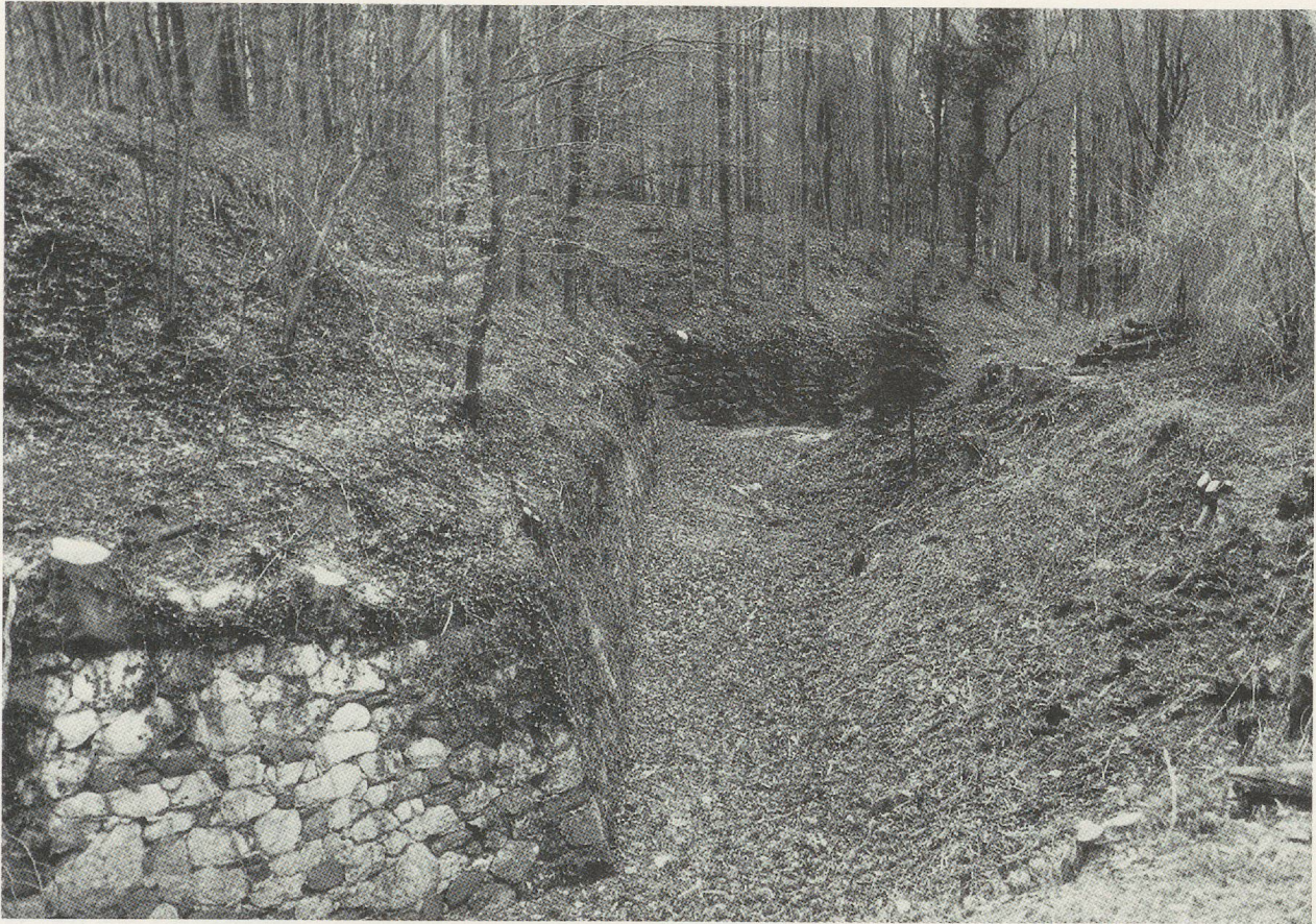
Fig. 65 Le mur d'escarpe de l'extension de la Grande Tenaille est une maçonnerie de pierres sèches particulièrement bien appareillée. Au-dessus, le rempart de terre.
