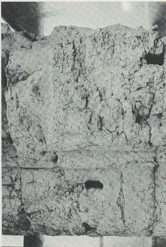
4. Section de l'architrave et tenon triangulaire pour le voussoir de l'arc de décharge, vus de l'est.
