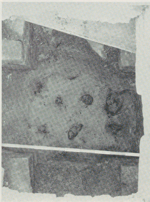
2. Pilotis fondant les égouts n os 1 et 3 à leur intersection, prélevés pour examen dendrochronologique.
