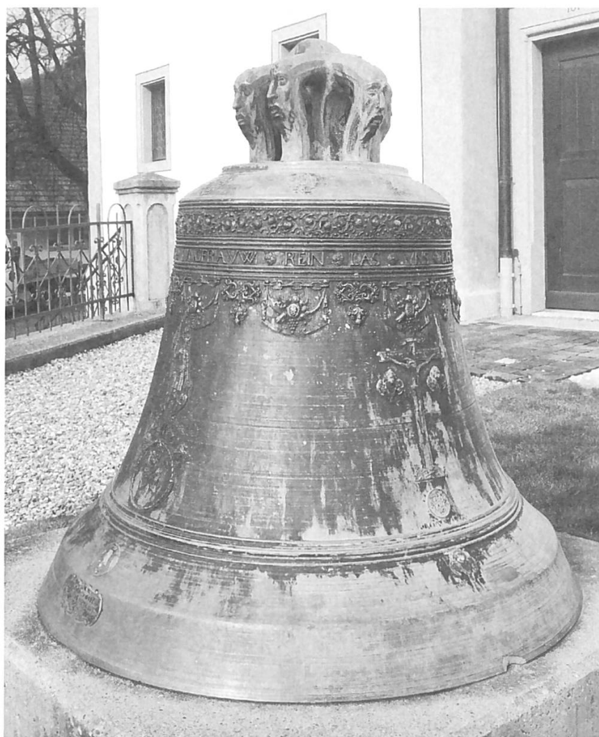
Abb. 11: Egerkingen, kath. Kirche. Abgestellte g'-Glocke von Franz Ludwig Kaiser, 1722. Mit dem kantigen Schlagring und dem andersartigen Radialverlauf im Obersatz unterscheiden sich die Glocken Franz Ludwigs von jenen seiner Nachfolger. – Foto Autor, 2018.
