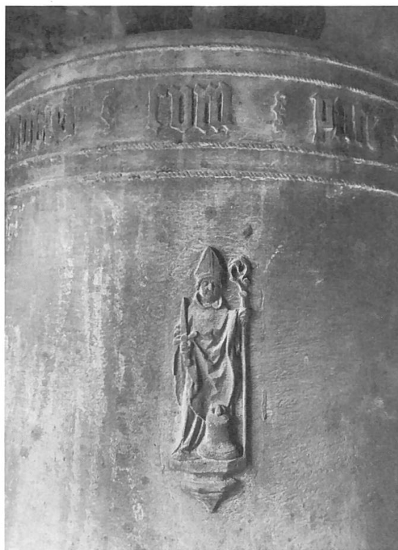
Abb. 7: Messen. Die von Peter Füssli 1516 gegossene f'-Glocke zeigt Reliefs der hl. Maria, Mauritius und Theodul. Die doppelten Schnurstege, welche die Minuskelinschrift einrahmen, sind ein typisches Kennzeichen damaliger Füssli-Glocken. – Foto Autor, 2024.
