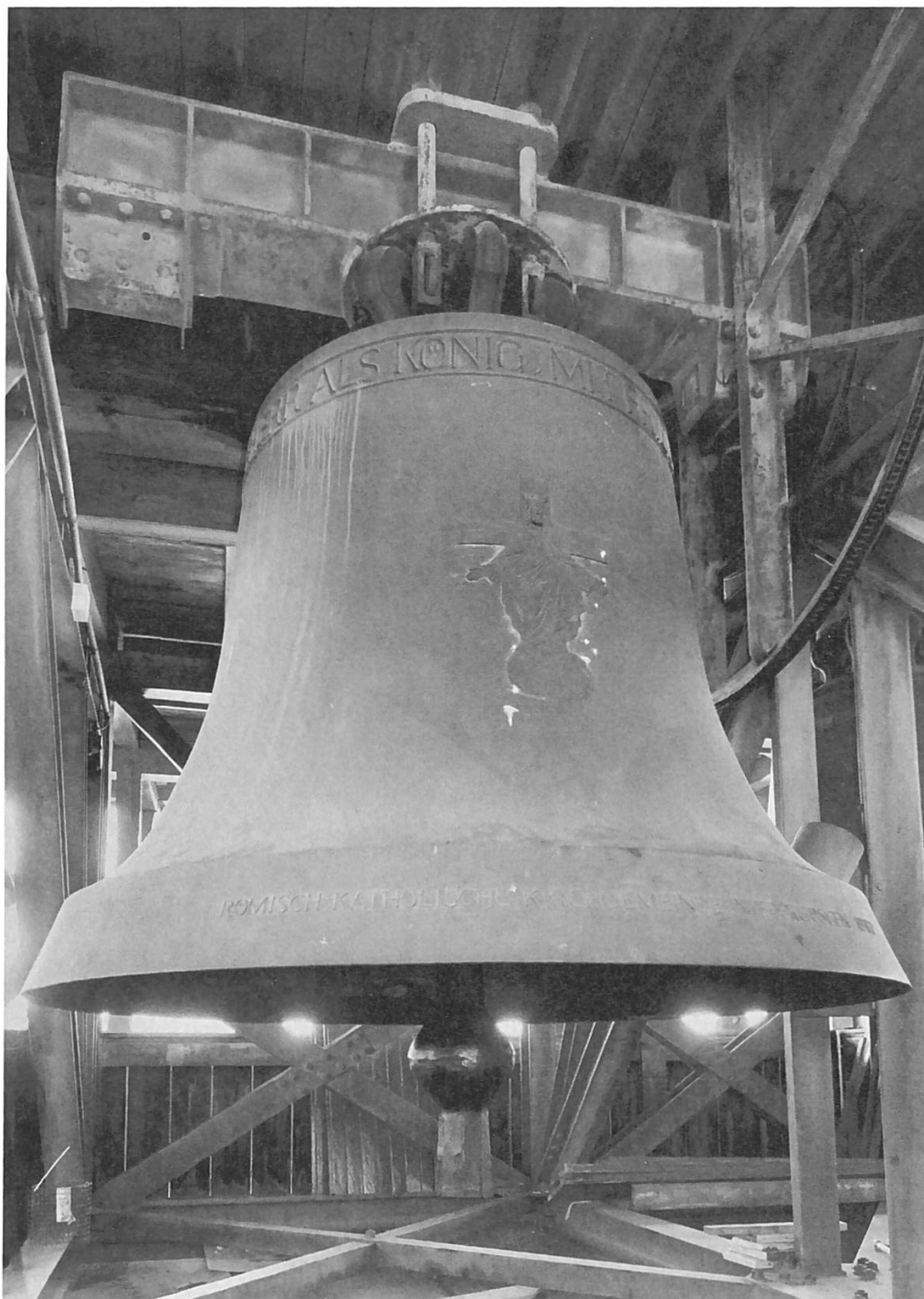
Abb. 23: Niedergösgen, kath. Kirche. Die grösste Glocke des Kantons (ges°, 7020 kg, Dm 226 cm), gegossen 1962 von Rüetschi AG in Aarau. Klöppel aus den 1990er Jahren, zugunsten deutlich verbesserter Tongebung eingekürzt 2023. – Foto Autor, 2023.
