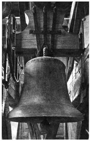
Abb. 2: Wil, Kreuzkirche; Grosse as°-Glocke mit typischem Kugel-Klöppel, wie sie ca. 1990–2010 vielerorts eingebaut worden sind. Die leichte Klangverbesserung gegenüber den Birnenklöppeln wurde mit deutlich mehr Masse im Ballen und zumeist höherer Glockenbelastung erkauft. – Foto: Autor.
