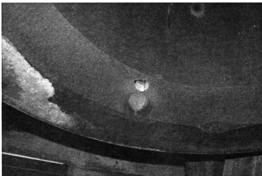
Abb. 6: Wittenbach SG, ref. Kirche. Neue (heller glänzende) Klöppelanschlagsstelle über der richtig sitzenden alten Stelle. Trotz verbessertem Klöppel wirkt sich die zu hohe Hängung klanglich nachteilig aus. – Foto: Autor.
