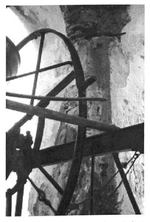
Abb. 5 - Oberalb der Bildmitte das am Rad befestigte eiserne «L», darunter der Puffer (Feder und Querbalken), welcher ein Schwingen der Glocke über 180<sup>0</sup> hinaus verhindert.
