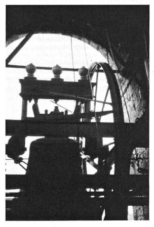
Abb. 1 - Gusseiserner Balken als Gegengewicht oberhalb des Jochs. Die drei Guss-Kugels von je 8-12kg dienen zur Feinabstimmung des Gegengewichtes. - Rechts im Bild ist der tiefliegende Drehpunkt der Achse deutlich sichtbar
