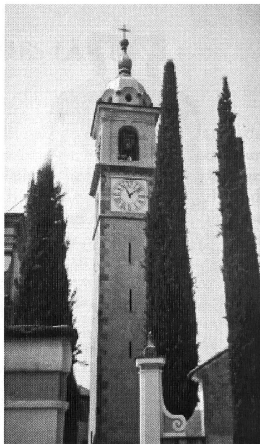
Abb. 4 - Die Bauweise der schlanken Campanili (hier Pfarrkirche Gentilino) erklärt die Wahl des Aufhängungssystems mit fallendem Klöppel aus statischen Gründen.
