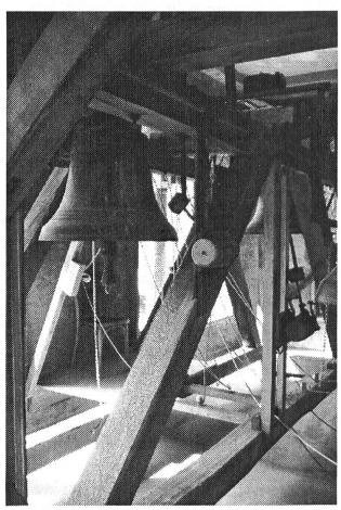
Abbaye de St-Maurice Les cordes du carillon valaisan restauré Seilzüge des restaurierten Walliser Carillons
