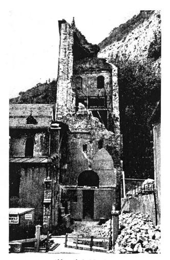
Abbaye de St-Maurice Le clocher après la chute du rocher en 1942 Der Glockenturm nach Einsturz der Felswand
