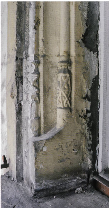
Fig. 4 Détail des congés à douilles de la fenêtre du logis de la Mère Abbessse (aile orientale)
