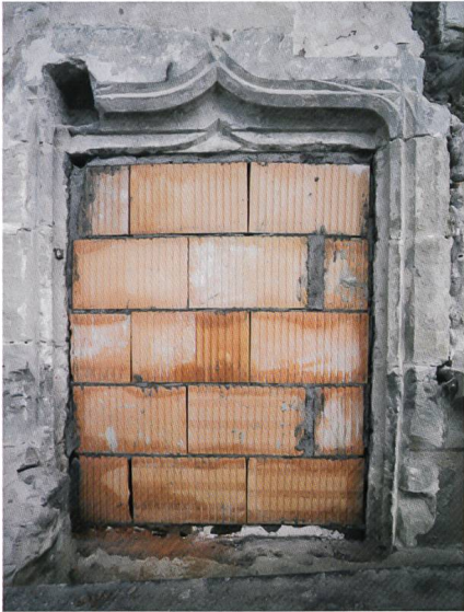
Fig. 3 Encadrement de la porte des anciennes latrines (aile sud) après son dégagement
