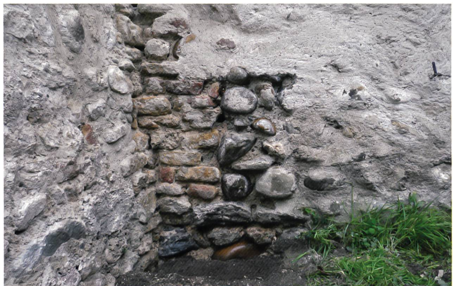
Abb. 3 Östlich an den Turm angrenzender Abschnitt der Stadtmauer mit Abrissgrenze und Füllung, die im Verband mit dem Turm gemauert worden ist; Blick nach Süden
