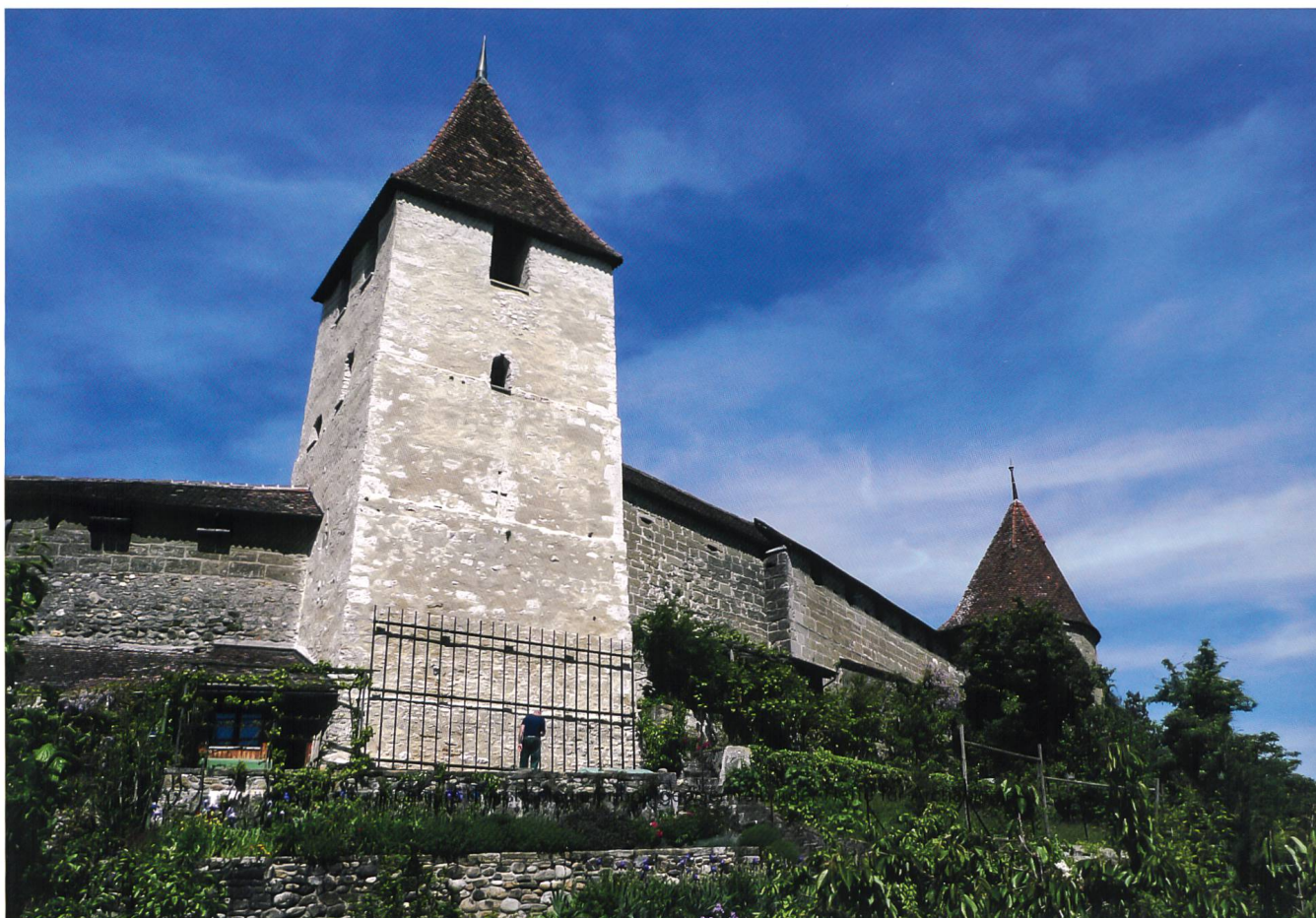
Abb. 1 Roter Turm nach der Renovierung und Schaalturm (hinten), dazwischen Stadtmauer mit teilweiser Aufdopplung (Mauerknick); Blick nach Norden
