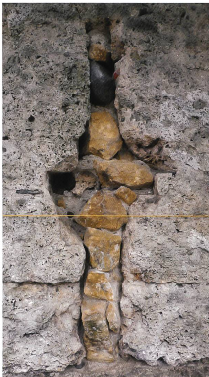
Abb. 7 Eine Kreuzscharte während der Freilegung
