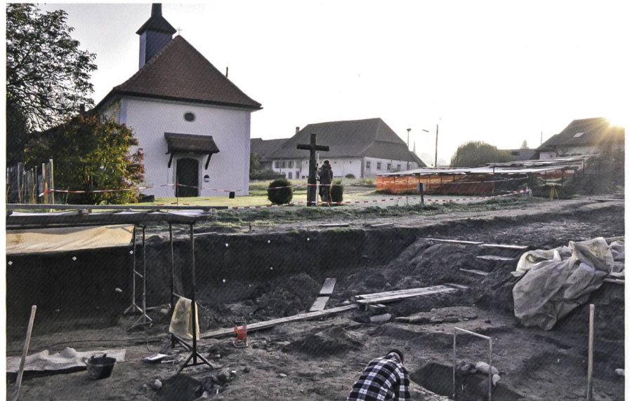
Fig. 1 La chapelle Notre-Dame-de-Compassion avec, à l'avant, une partie de l'un des secteurs ouverts en 2013, en cours de fouille
