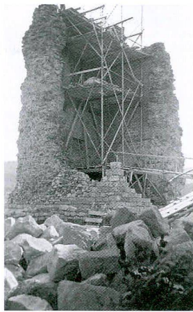
Fig. / Abb. 9 Les travaux de consolidation de 1947 Die Sicherungsarbeiten im Jahr 1947
