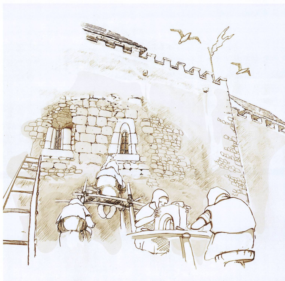
Abb. 10 Im Bereich des Kronenkellers werden Lichtscharten in die Stadtmauer eingebaut. Blick von aussen an die Stadtmauer
