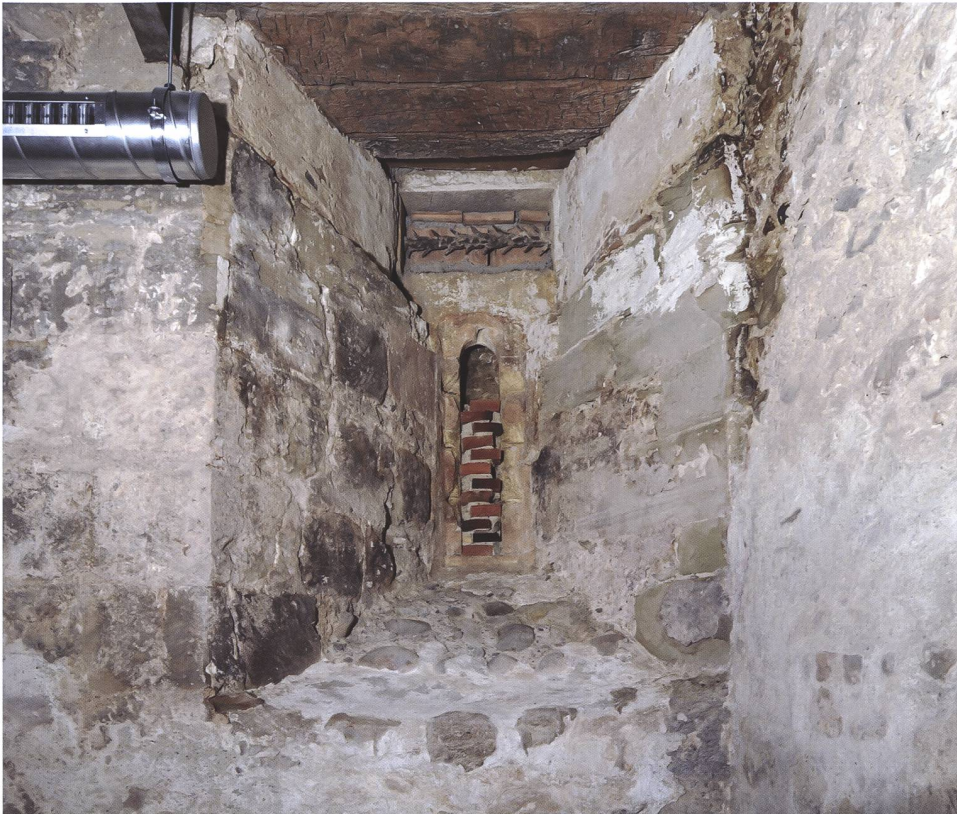
Abb. 11 Detail der verschlossenen östlichen Lichtscharte und der darüberliegenden jüngeren, ebenfalls hinterfüllten Lüftungsöffnung
