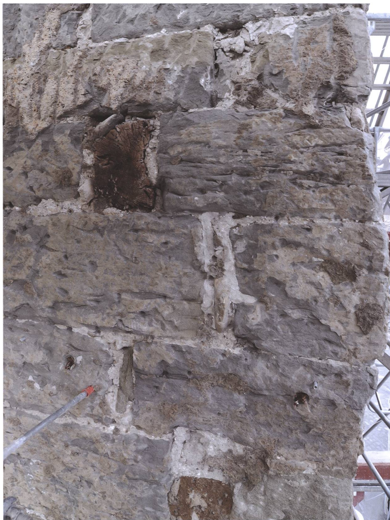
Fig. 5 Première phase, premier étage, tête de poutre en chêne de 1251-1267 liée à la maçonnerie de la muraille
