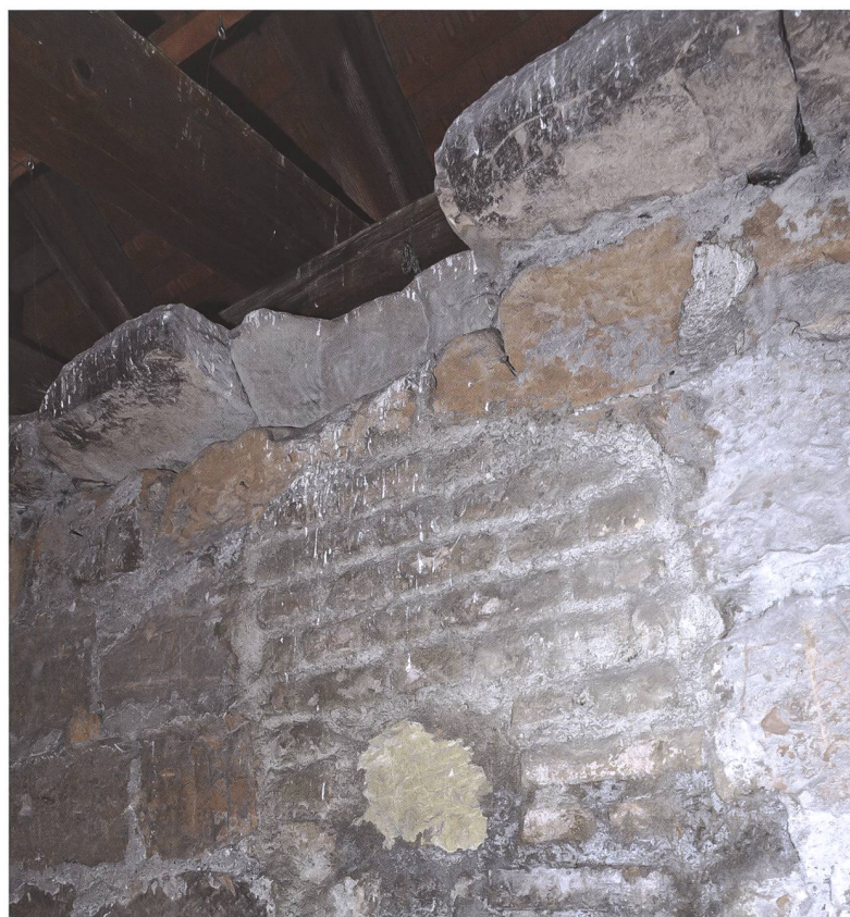
Fig. 26 Tour-porte de Berne, couronnement à dalles saillantes et traces de l'incendie de 1660
