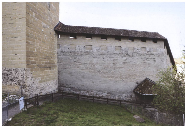
Fig. 30 Muraille attenante à la tour-porte de Berne, courtine à proximité de la tour des Chats avec son crénelage primitif
