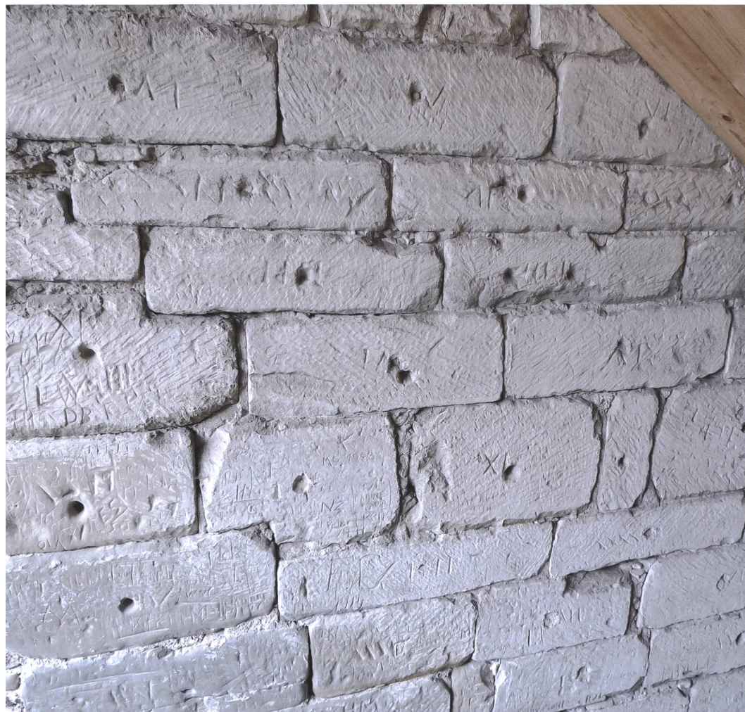
Fig. 69 Murten/Schimmelturm, marques de hauteur d'assise
