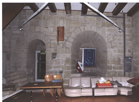
Fig. 4 Tour de Dürrenbühl, troisième niveau, mur est avec archère et porte
