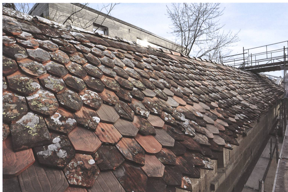
Fig. 65 Détail de la couverture de l'enceinte avant restauration, avec son mélange de tuiles utilisées entre le XV e et le XX e siècle
