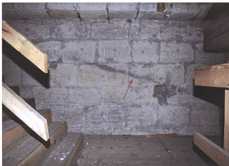
Fig. 20 Tour des Chats, mur est, traces de la toiture primitive au cinquième niveau (flèche)
