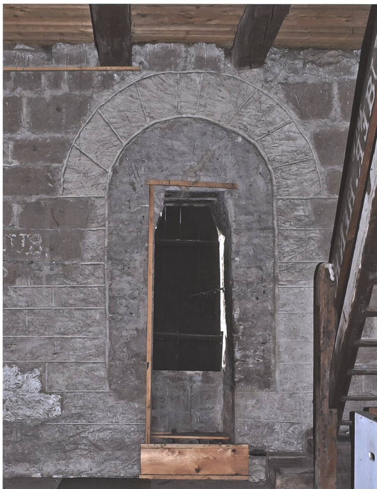
Fig. 28 Tour-porte de Berne, mur ouest, baie du quatrième niveau avec renfort de briques (1660)
