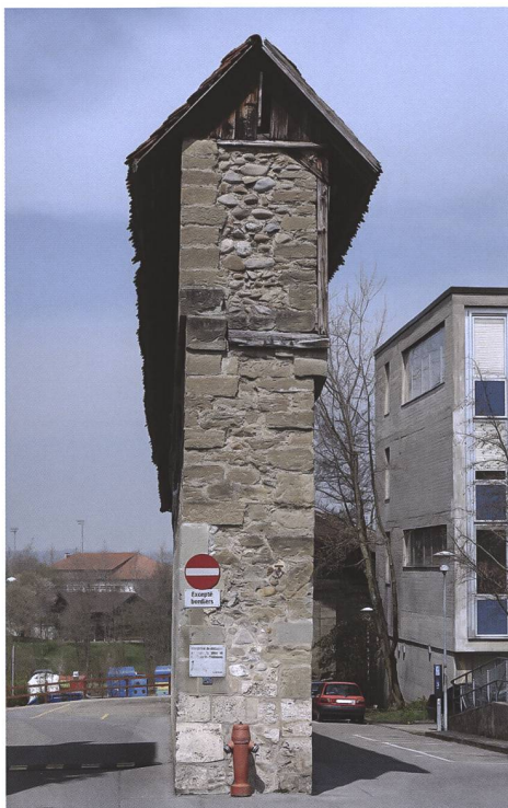
Fig. 64 Extrémité coupée de l'enceinte au sud de la tour du Blé faisant ressortir les parements et le blocage
