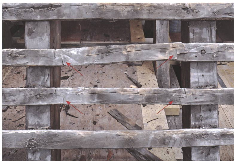
Fig. 21 Tour des Chats, péclose dans le lattage d'origine (1424/1425) avec indication des découpes effectuées sur les lattes amovibles (flèches)
