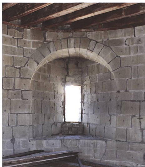
Fig. 39 Tour Henri, archère simplement ébrasée du quatrième niveau
