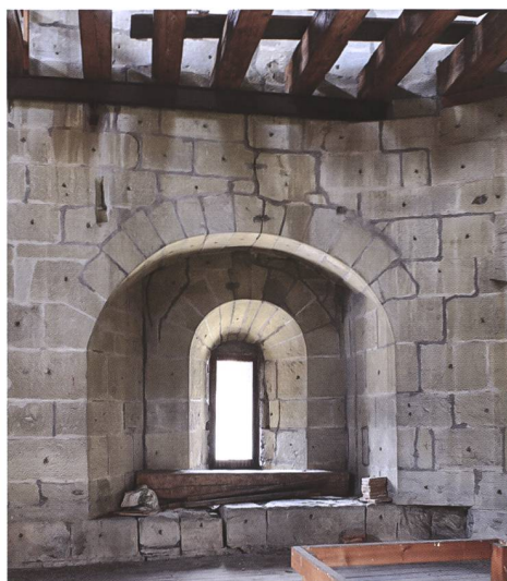
Fig. 38 Tour Henri, archère à niche trapézoïdale du troisième niveau
