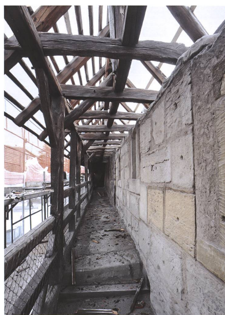
Fig. 63 Vue de l'enceinte au sud de la tour du Blé durant les travaux, avec son chemin de ronde de 1410/1412 et sa charpente de 1444/1445
