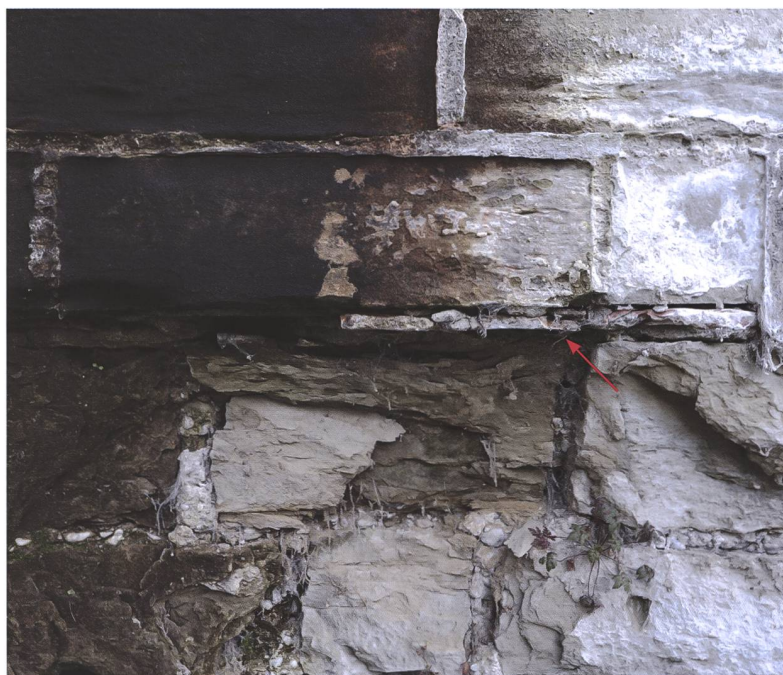
Fig. 34 Muraille en amont de la tour des Chats, lit de tuiles (flèche) marquant la limite entre le mur médiéval et la reconstruction de 1915/1924
