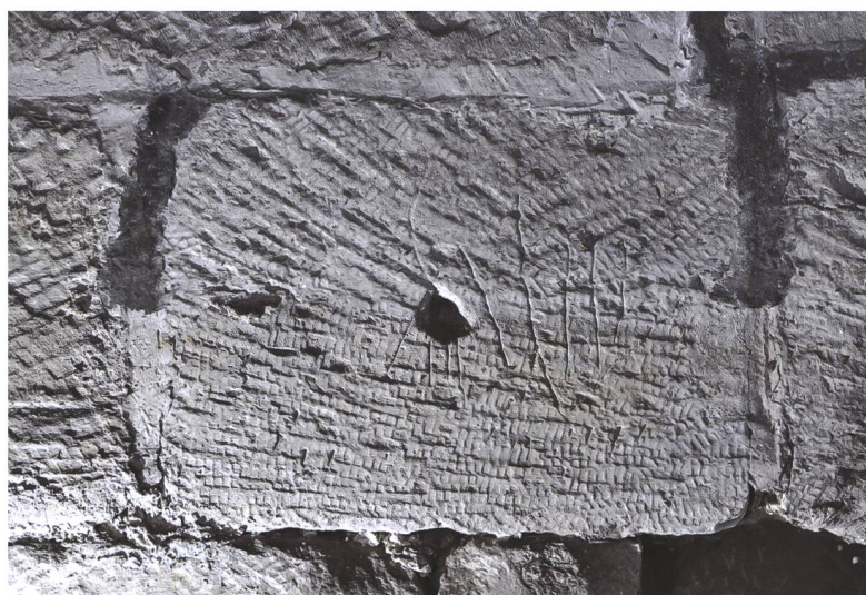
Fig. 43 Tour Henri, marque de hauteur d'assise tracée deux fois sur le même bloc au troisième niveau
