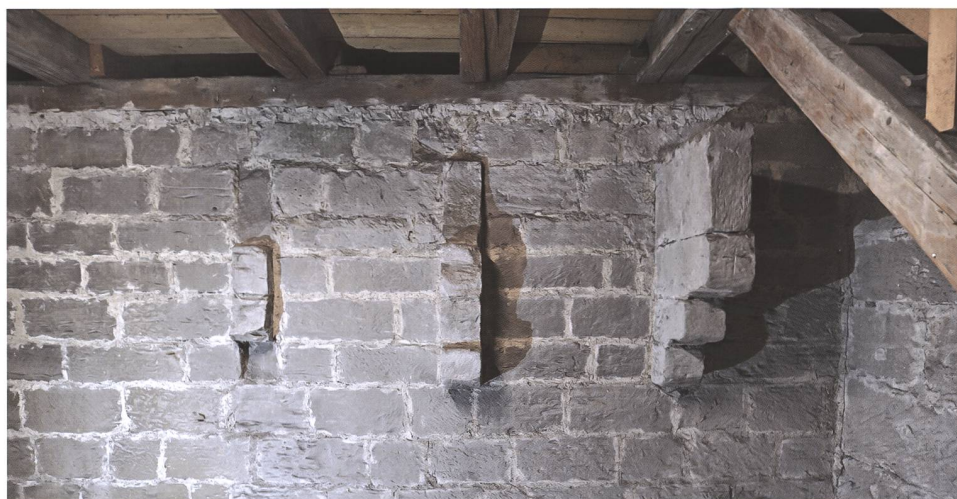
Fig. 27 Tour-porte de Berne, consoles de la bretèche surmontant la porte primitive (2 e moitié XIII e siècle)
