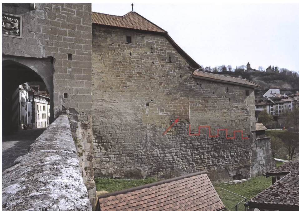
Fig. 33 Muraille attenante à la tour-porte de Berne, avec indication de l'ancien crénelage (surlignage rouge) et traces de l'incendie de 1340 (flèche)
