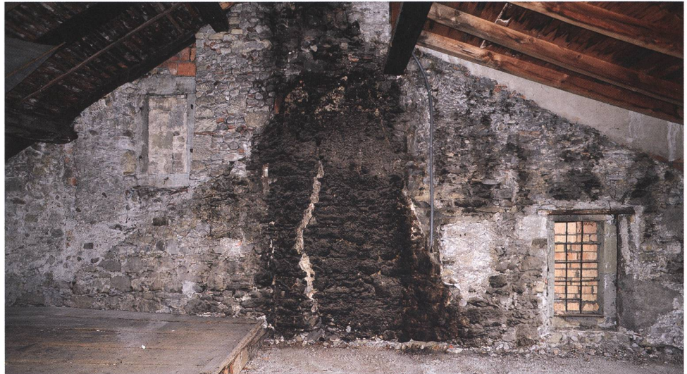
Fig. 6 Combles, mur mitoyen sud, traces de la borne et fenêtre créée dans le mur pignon du XV e siècle ultérieurement murée (tache claire à droite)
