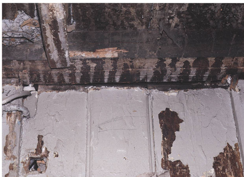
Fig. 17 Premier étage ouest, détail de la cloison est datée du XVIII e siècle ou antérieure
