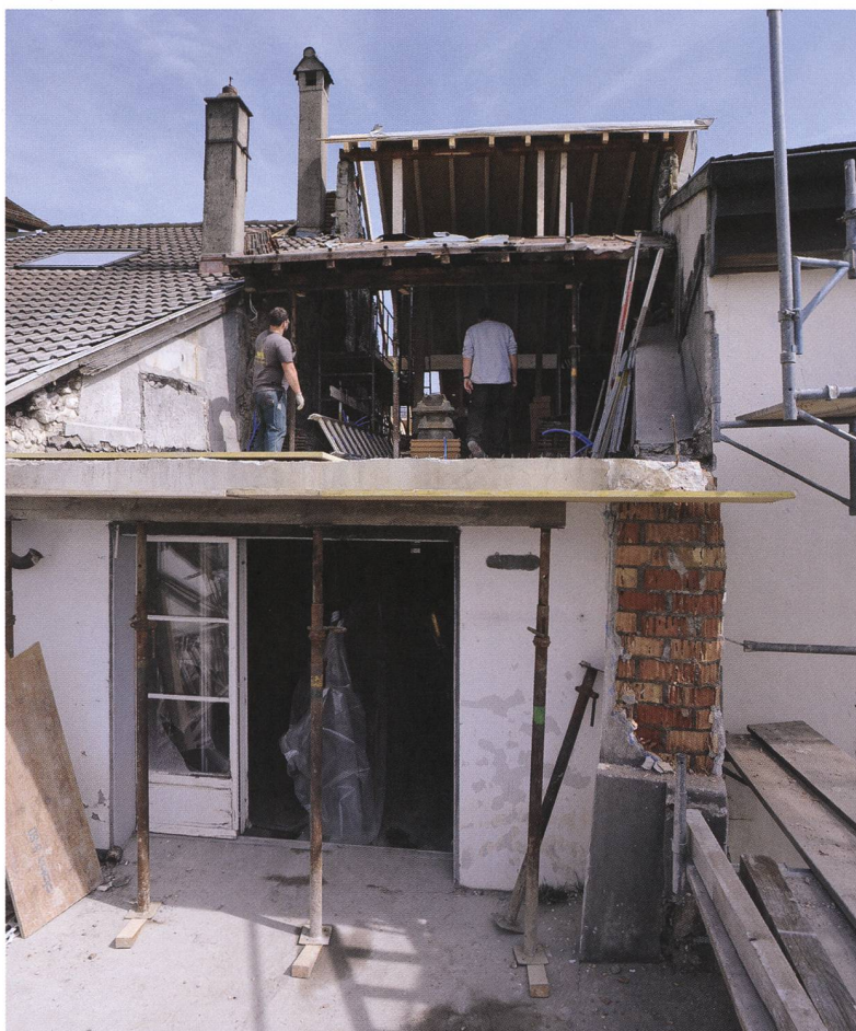
Fig. 19 Deuxième étage et combles ouest, terrasses créées durant les travaux du XX e siècle
