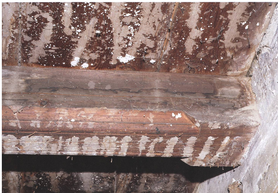
Fig. 12 Premier étage ouest, détail de la poutraison de 1557/1558
