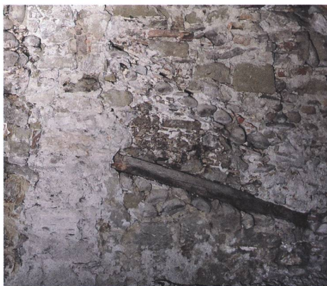
Fig. 5 Combles, mur mitoyen nord, chevron de 1259
