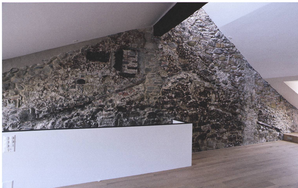
Fig. 4 Combles, mur mitoyen nord avec les différents niveaux de la toiture, après restauration ; en bas à droite, le chevron de 1259
