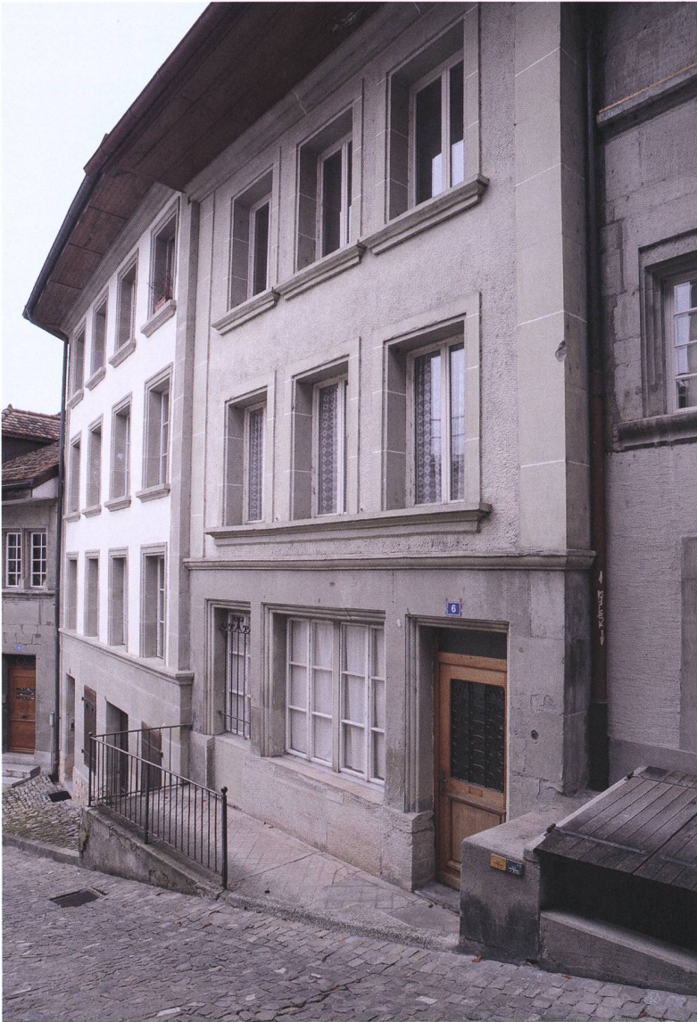
Fig. 3 Façade sur rue avec son crêpi d'origine, état en 2012, avant les travaux
