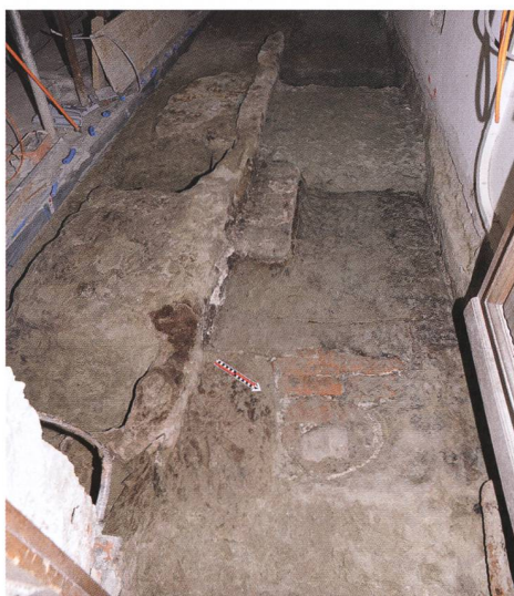
Fig. 20 Rez-de-chaussée, ancien dallage du couloir et marche de l'accès à la boutique utilisée après 1529
