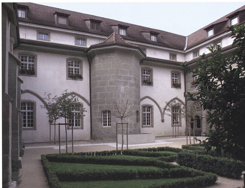
Fig. 15 Mur de fond du cloître gothique et tracé au sol de la galerie vus depuis le jardin intérieur
