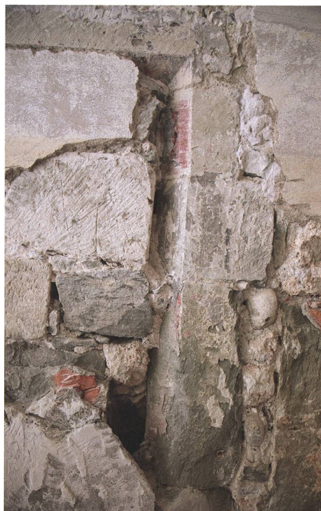
Fig. 18 Percement avec chanfrein et encadrement peint probablement aménagé à la fin du XVI e siècle
