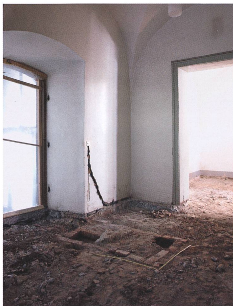
Fig. 20 Vestiges du fourneau mis au jour dans la salle des moines (n° 5)
