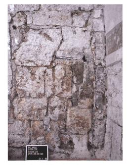
Fig. 4 Paroi est de l'aile sud, en tuf
