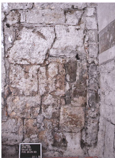
Fig. 4 Paroi est de l'aile sud, en tuf
