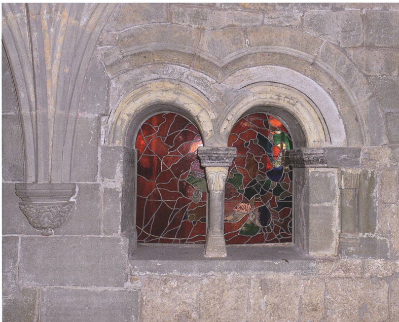
Fig. 5 Baie géminée romane de la salle capitulaire
