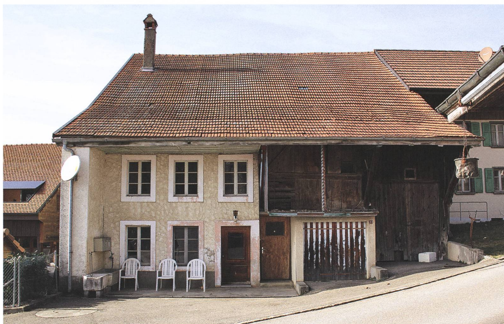
Abb. 3 Haus an der Chemin de l'École 5 in Montet, in dem 1950 der Münzhort bei Umbauarbeiten entdeckt wurde
