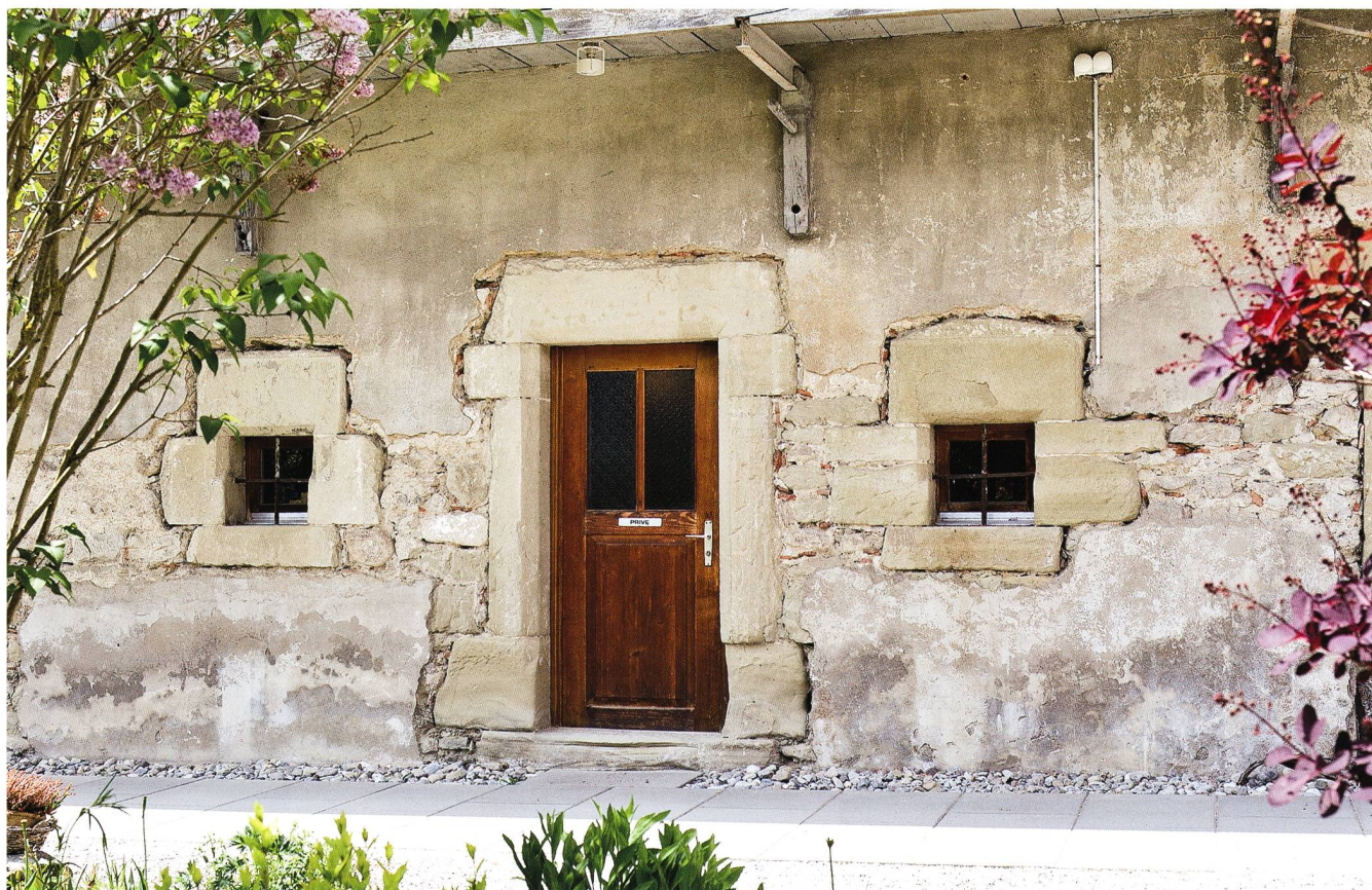
Fig. 17 État IV: détail de la façade orientale de l'aile ouest des bâtiments conventuels après sa reconstruction à la fin du XVI e siècle
