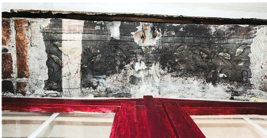
Fig. 12 Fribourg/Planche-Inférieure 41. Vestige de décor peint sur le voûtain de la fenêtre est du premier étage sur rue, deuxième moitié du XVI e siècle
