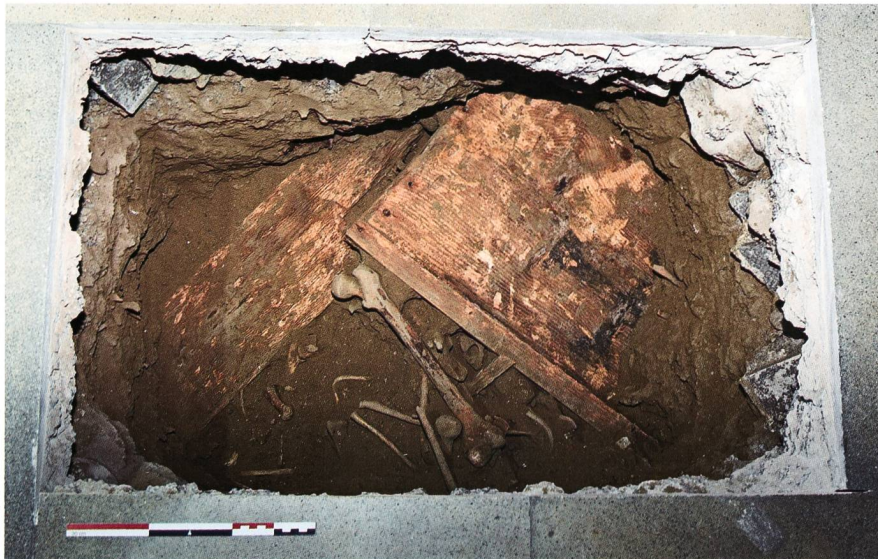
Fig. 25 Romont/Collégiale. Sondage dans la nef: cercueil en bois, ossements et poutre en bois
