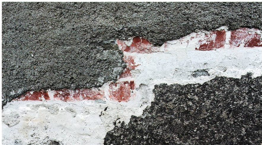
Fig. 28 Vuippens/Château de Sorens. Vestiges du décor de fausses briques sur le mur nord de la tour d'escalier daté de 1468
