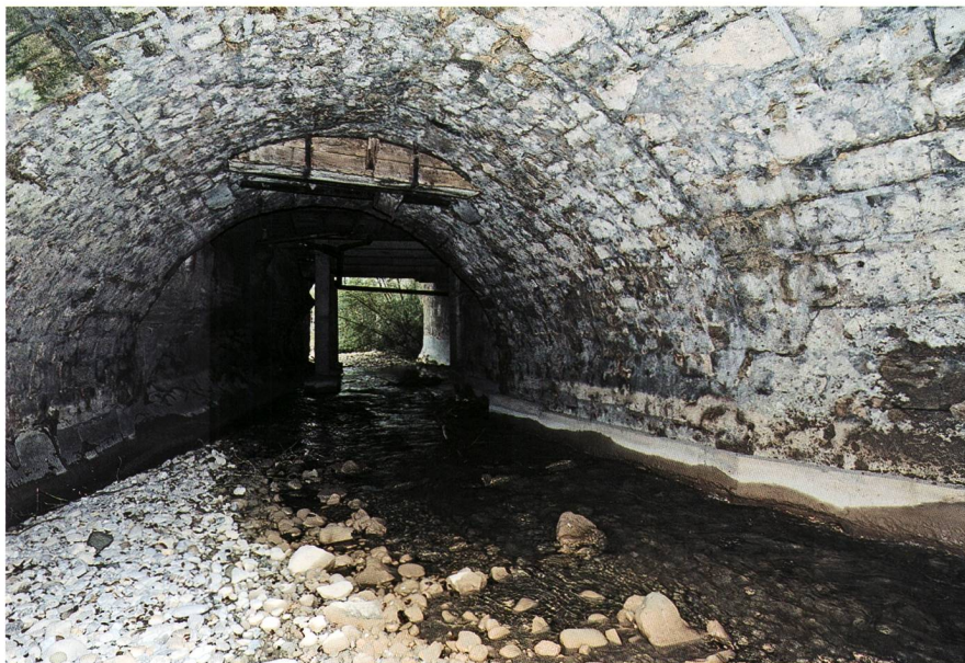
Fig. 13 Fribourg/Rue des Forgerons. Voûtes supportant la fontaine de la Fidélité et la chaussée sur le Gottéron
