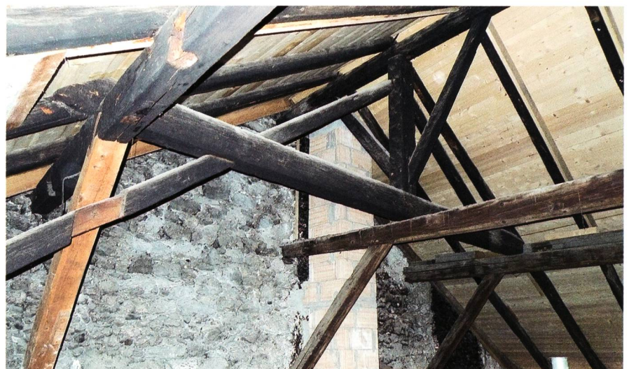
Abb. 6 Der Dachstuhl mit Blattsasse im Steigband und nachträgliche Abstützungen (alle modernen Bauteile sind aus hellerem Holz), Blick gegen die Brandmauer West
