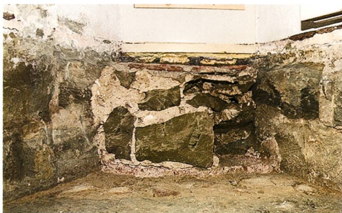
Fig. / Abb. 18 Aile orientale, base de la fenêtre nord de l'ancienne salle d'étude avec son revêtement de mortier au tuileau sous le bouchon du XIV e ou XV e siècle Ostflügel, Basis des nördlichen Fensters im ehemaligen Studierzimmer mit Verputz aus Ziegelschrotmörtel (schmales Band unten) unterhalb einer Füllung, die im 14. oder 15. Jahrhundert eingebracht wurde
