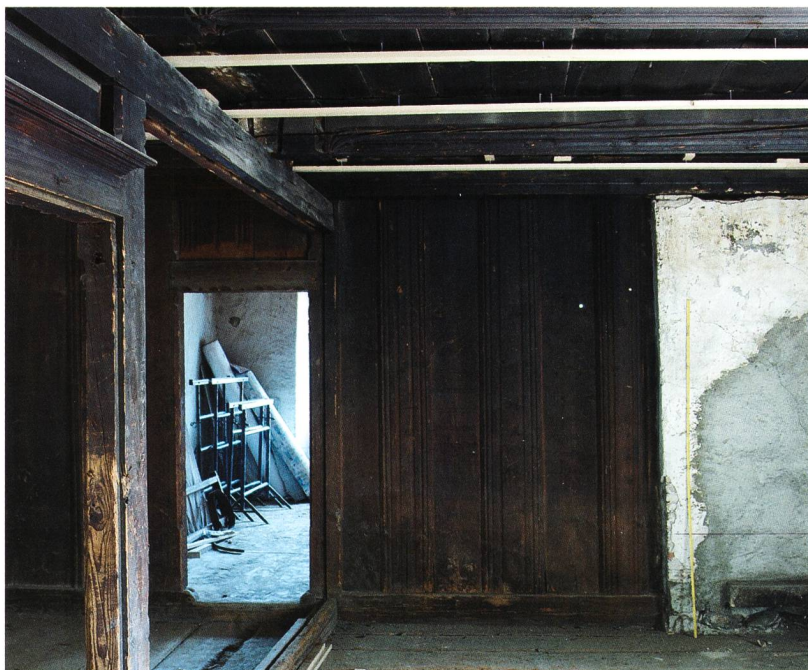
Fig. / Abb. 30 Maison de Prez-Maillardoz, bâtiment 3, cloison de planches de bois du deuxième étage, milieu du XVI e siècle Haus der Prez-Maillardoz, Gebäude 3, Zwischenwände aus Holz im zweiten Stockwerk, Mitte 16. Jahrhundert
