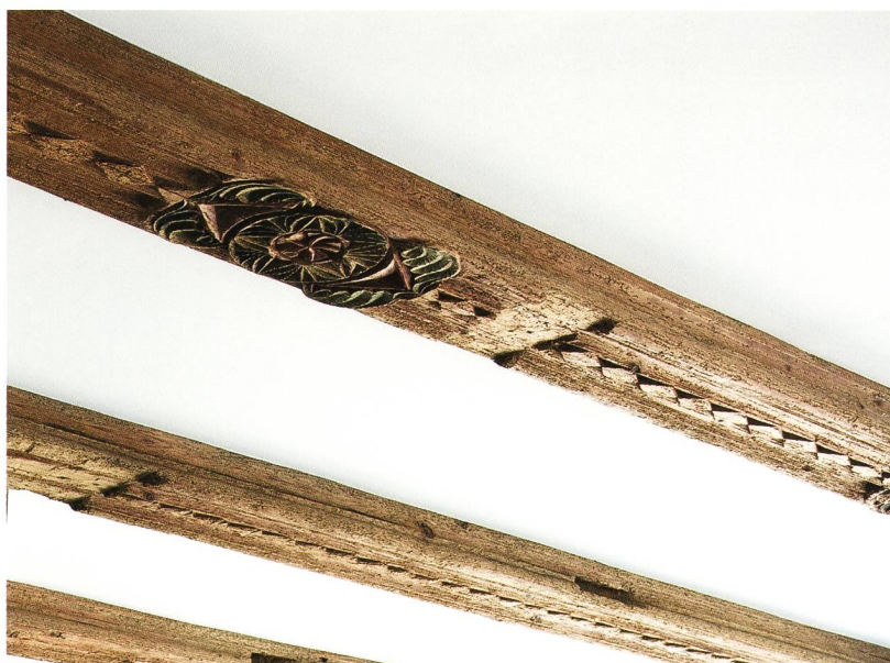
Fig. / Abb. 29 Maison de Prez-Maillardoz, bâtiment 1, premier étage nord-est, poutraison du XVI e siècle Haus der Prez-Maillardoz, Gebäude 1, nordöstliches erstes Stockwerk, Balkenlage aus dem 16. Jahrhundert
