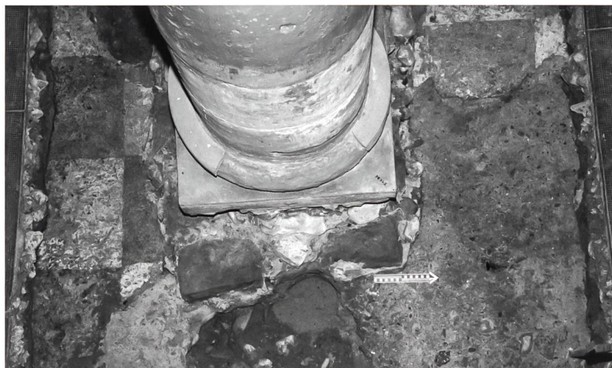
Fig. 10 Fribourg/Abbaye de la Maigrauge. Détail du sol de mortier en damier rouge et blanc découvert dans l'aile orientale, après 1262
