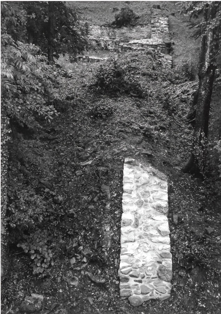
Fig. 5 Bossonnens/Château. Segment du mur d'enceinte fraîchement consolidé (vue vers le sud)
