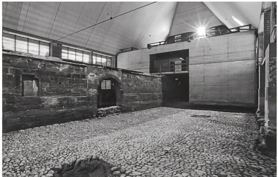
Fig. 13 Fribourg/Grand-Werkhof. Pavage de 1556 avec, à gauche, la façade nord de 1415/1417 dans laquelle a été percée une porte en 1556 et à droite, la façade sud de 1822/1824
