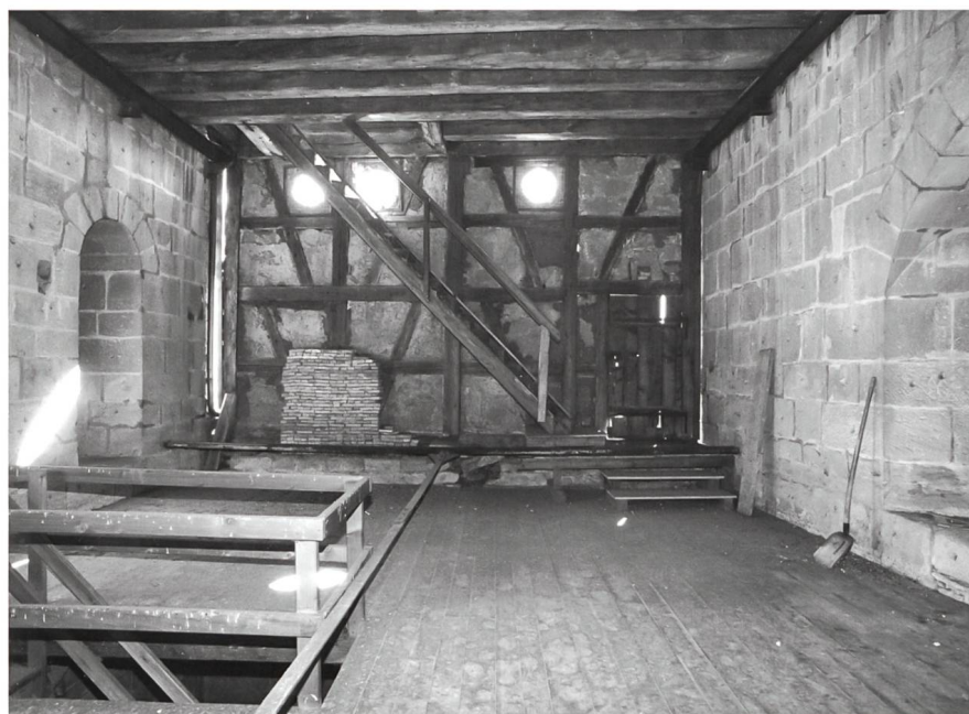
Fig. 15 Fribourg/Tour Henri. Deuxième étage, poutraison de sapin blanc datant de 1410/1411, escalier en épicea de 1411/1412, paroi côté ville de 1647/1649
