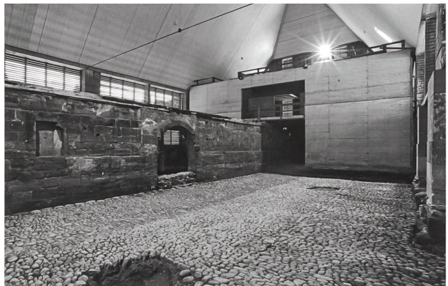
Fig. 13 Fribourg/Grand-Werkhof. Pavage de 1556 avec, à gauche, la façade nord de 1415/1417 dans laquelle a été percée une porte en 1556 et à droite, la façade sud de 1822/1824
