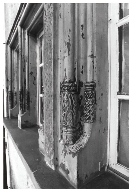
Fig. 14 Fribourg/Rue de la Samaritaine 28. Détail des congés à douilles gothiques / Renaissance du premier étage, seconde moitié du XVI e
