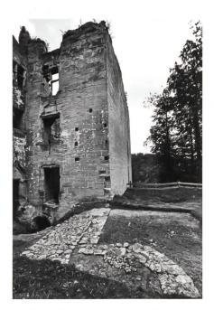
Fig. 5 Sondage 1: structures maçonnées annexes au pavillon de chasse et chemin en galets; à signaler, sur la façade ouest du pavillon, les empochements des poutres
