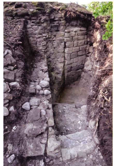
Fig. 3 Le sondage 3 à l'intérieur de l'esplanade avec le mur d'enceinte et l'un de ses contreforts; au premier plan, le seuil en molasse
