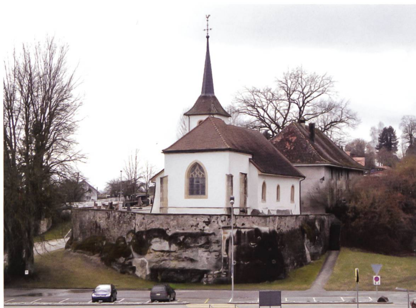
Fig. / Abb. 1 L'église Saint-Pierre de Carignan vue de l'est Blick von Osten auf die Petrus- kirche von Carignan
