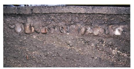
Abb. 17 Murten/Lausannestrasse. Alte Strassenpflästerung unterhalb der modernen Strasse
