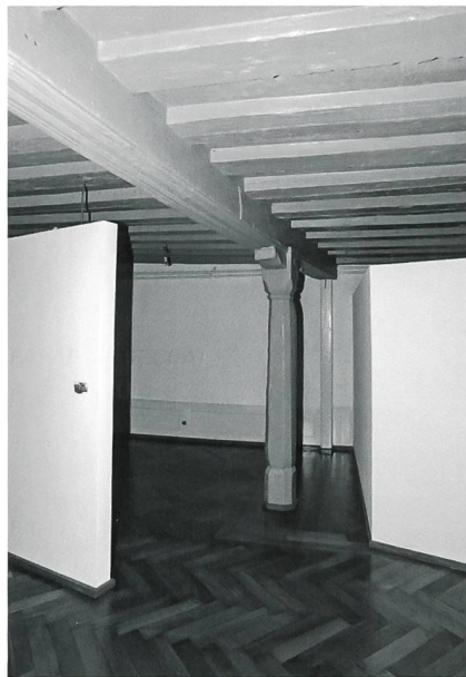
Fig. 12 Fribourg/Stalden 10. La salle du premier étage datée vers 1546 après les transformations
