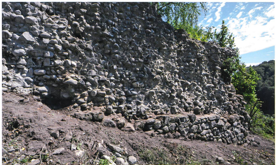
Fig. 16 Montagny-les-Monts/Pré-de-l'Étang. Tronçon de l'enceinte du XII e siècle au sud-est du donjon, après nettoyage
