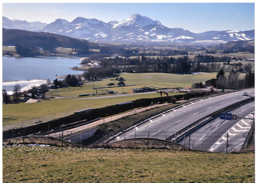
Fig. 2 Avry-devant-Pont/La Fin. La tranchée du gazoduc longeant l'autoroute
