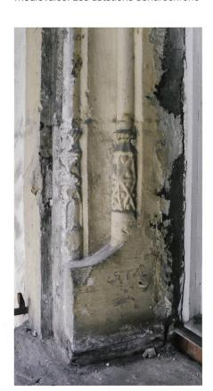
**Fig. 4** Détail des congés à douilles de la fenêtre du logis de la Mère Abbesse (aile orientale)
