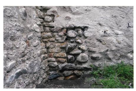
Abb. 3 Östlich an den Turm angrenzender Abschnitt der Stadtmauer mit Abrissgrenze und Füllung, die im Verband mit dem Turm gemauert worden ist; Blick nach Süden
