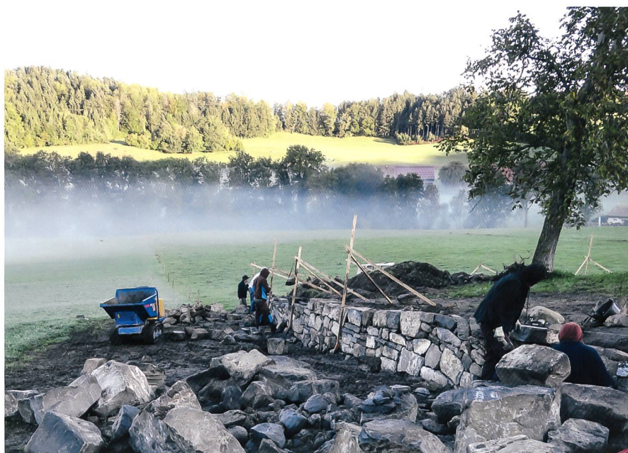
Fig. 2 Reconstruction du mur en pierres sèches
