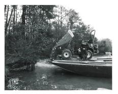
Fig. 3 Système de transport et de déchargement des galets mis en œuvre par l'armée
