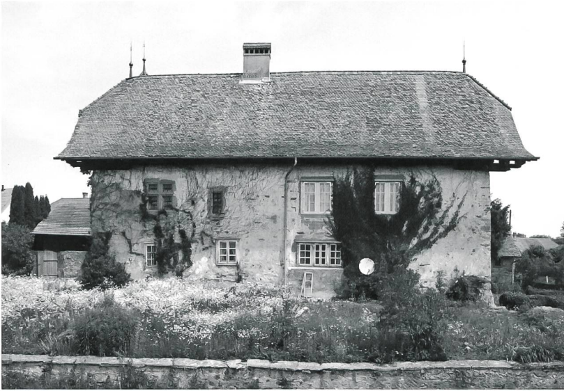
Fig. / Abb. 4 Façade sud, état en 2012 Südfassade, Zustand im Jahre 2012
