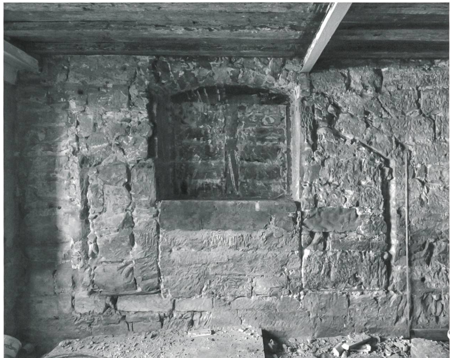
Fig. 13 Fribourg/Rue de la Samaritaine 40. Ancienne arcade (seconde moitié du XIV e siècle), puis fenêtre de l'échoppe du rez-de-chaussée (XVI e siècle)
