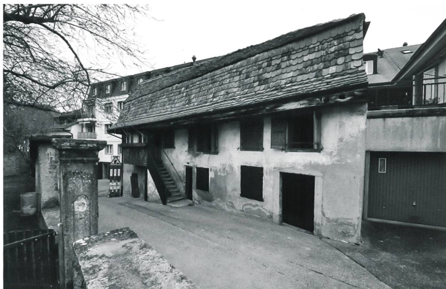
Fig. 8 Estavayer-le-Lac/Ruelle de la Fausse-Porte 6. Vue générale de la façade sud de la maison avant les travaux
