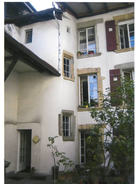
Abb. 18 Murten/Hauptgasse 13. Hofseitige Ansicht mit älterem Treppenturm
