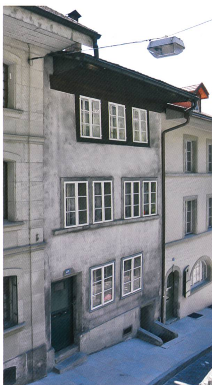
Fig. 1 Fribourg/Grand-Fontaine 29. Façade sur rue avant restauration
