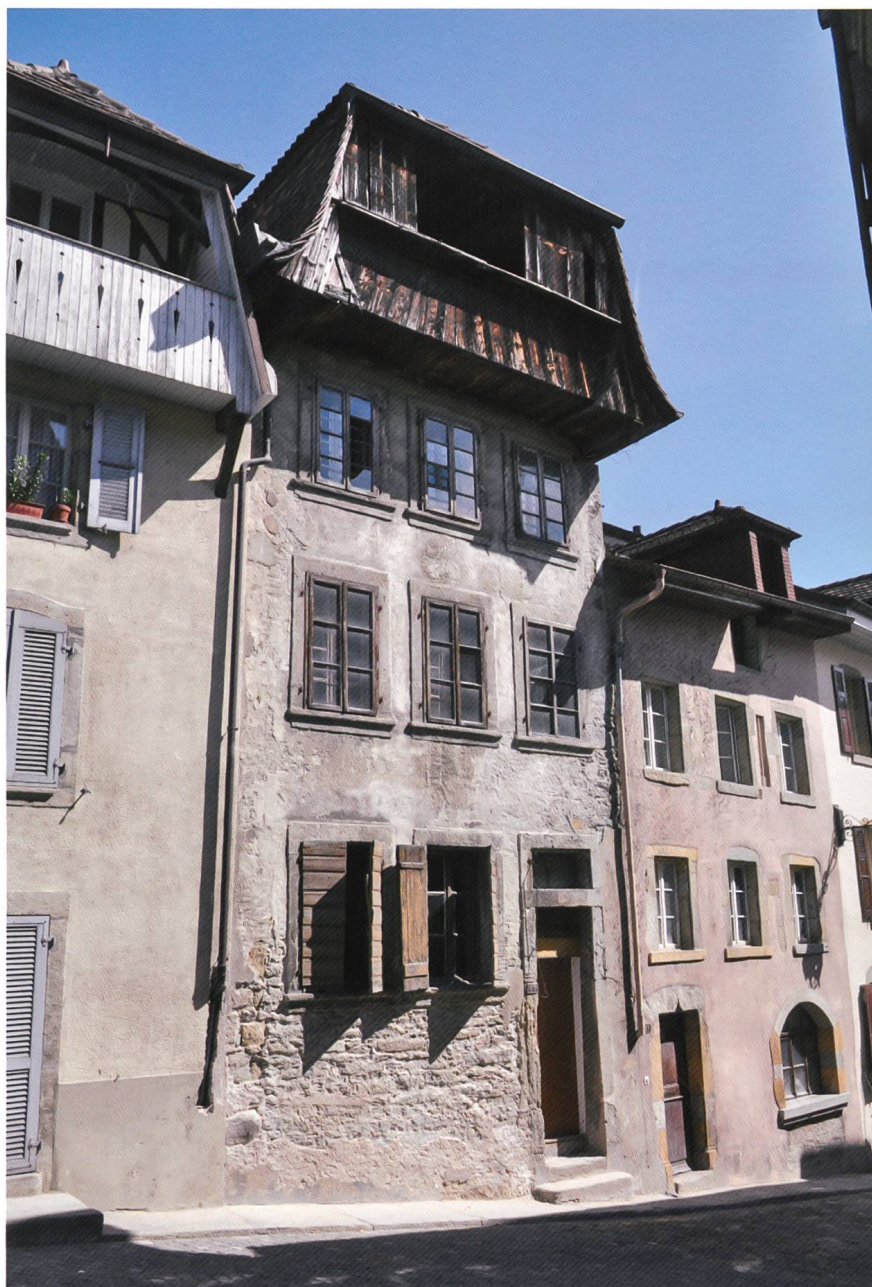
Fig. 1 Façade de la maison de la Grand-Rue 35
