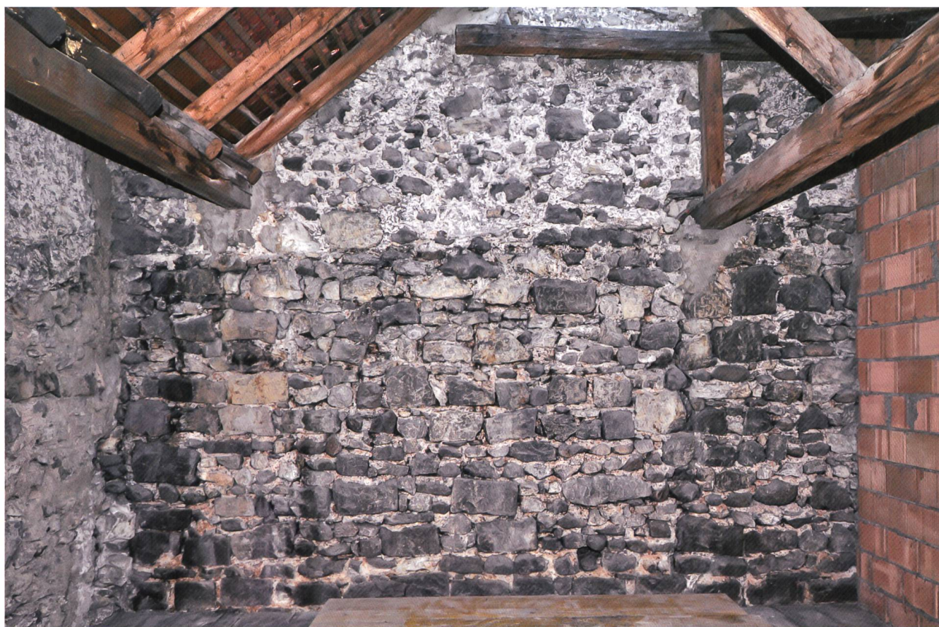
Fig. 8 Mur arrière (comble) avec traces encore visible d'une ancienne toiture
