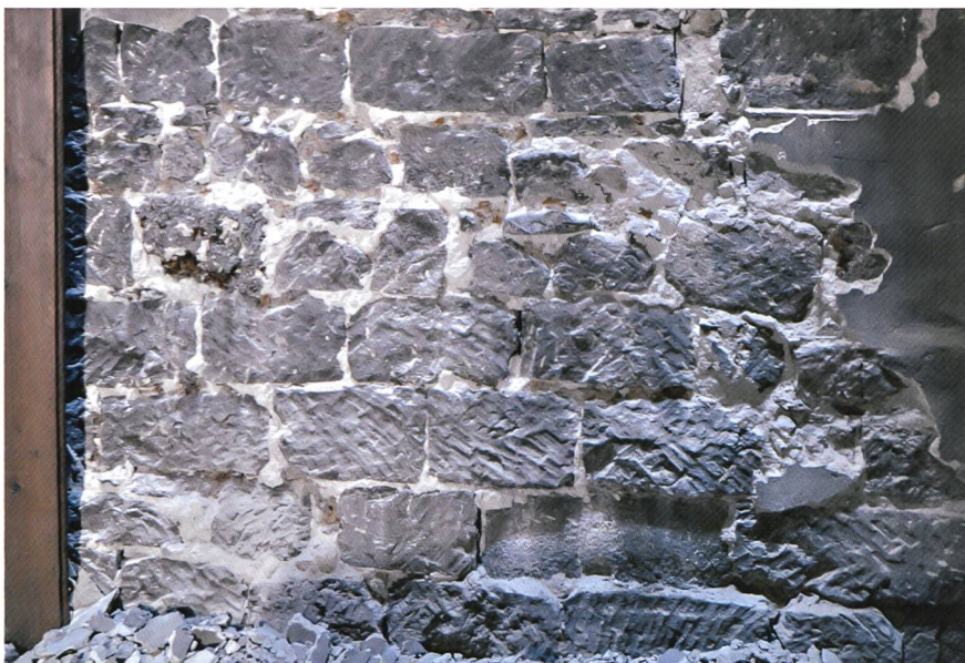
Fig. 7 Traces d'un marteau taillant sur le mur arrière (deuxième étage)
