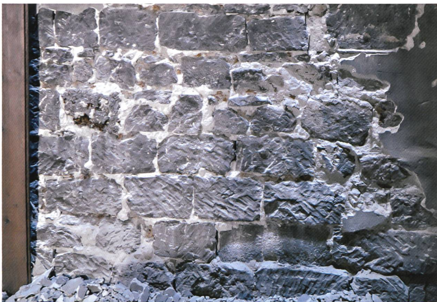
Fig. 7 Traces d'un marteau taillant sur le mur arrière (deuxième étage)
