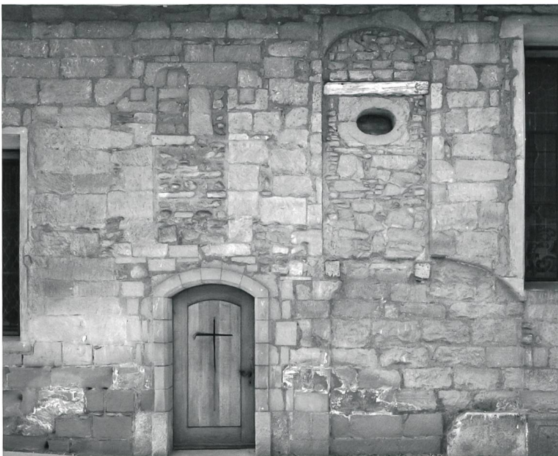
Abb. / Fig. 14 Teilansicht der Nordseite Vue partielle de la façade nord
