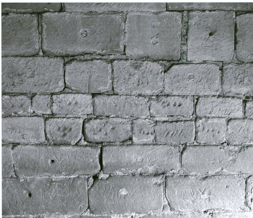
Abb. 5 Ausschnitt der inneren Westwand des Turmes mit Höhenmarkierungen der Quaderlagen
