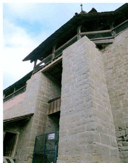
Abb. 2 Stadtseitig angesetzte Mauerzungen des Turmes
