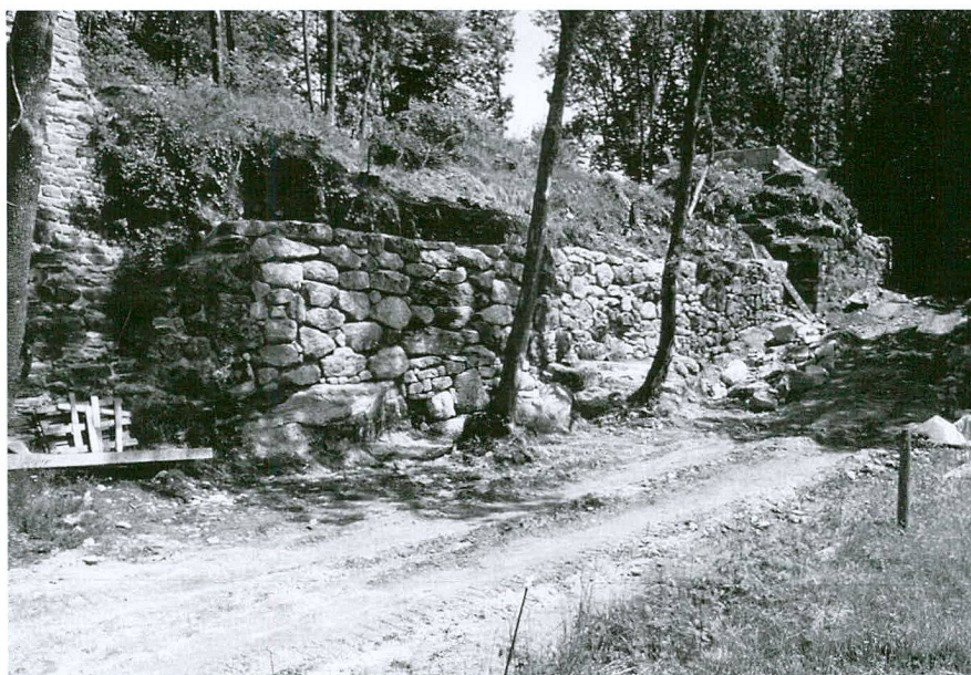
Fig. 3 Bossonnens/Château. Etat de la façade extérieure de l'enceinte occidentale en 2003: partie déjà consolidée (à gauche) et mur dit «mégolithique» se terminant par la tour quadrangulaire (à droite)
