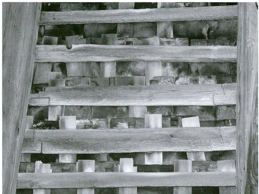
Fig. 8 Couverture du chemin de ronde, détail d'une péclouse (1650-1653)
