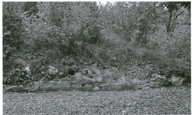
Fig. / Abb. 12 Vestiges d'un bâtiment (B.25) situé sur le flanc nord de la butte castrale Baureste eines Gebäudes (B.25) auf der Nordflanke des Burghügels
