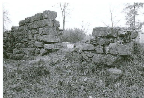
Fig. / Abb. 11 Mur de clôture oriental du château sud avec, au centre, le piédroit de porte encore conservé (état avant consolidation) Östliche Einfassungsmauer der südlichen Burganlage, in der Mitte der noch erhaltene Türpfeiler (vor der Konsolidierung)
