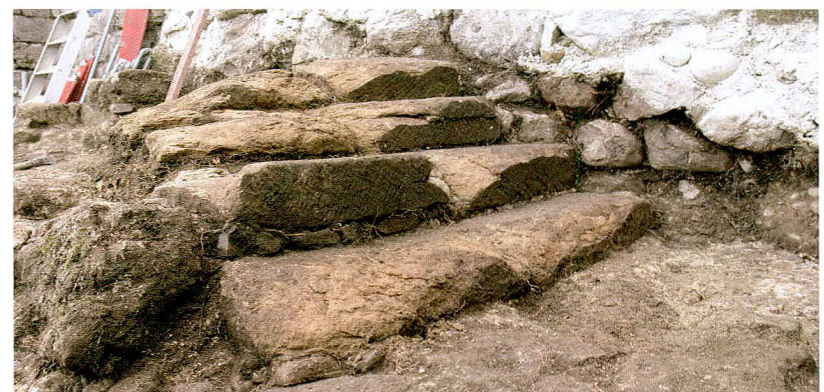
Fig. / Abb. 7 Corps de logis nord, détail de l'amorce de la volée d'escalier plaquée à la tour nord Nördliches Wohngebäude, Nahaufnahme vom Beginn des an den Nordturm angesetzten Treppenaufgangs
