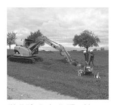
Abb. 29 Tafers/Bruchmatte. Während den maschinellen Sondierungen
