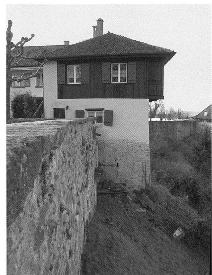
Fig. 8 Estavayer-Le-Lac/Place Saint-Claude 13. Vue générale de l'ancien corps de garde et de l'enceinte attenante
