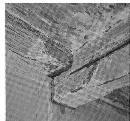
Abb. 15 Murten/Hauptgasse 19. Profile der Holzdecke im ersten Obergeschoss
