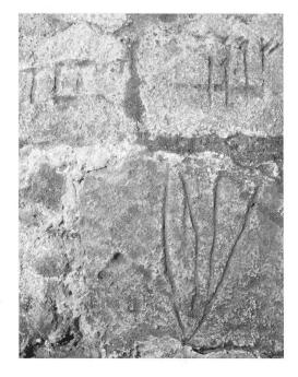
Abb. / Fig. 12 Höhenmarkierungen der Steinlagen im oberen Kellergeschoss Marques de hauteur d'assises dans la cave supérieure
