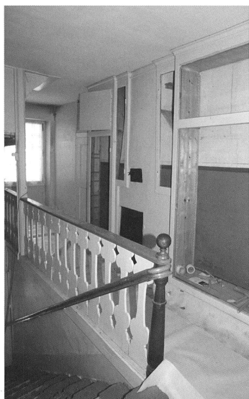
Abb. / Fig. 8 Korridor und Treppenlauf im Obergeschoss Corridor et montée d'escaliers à l'étage
