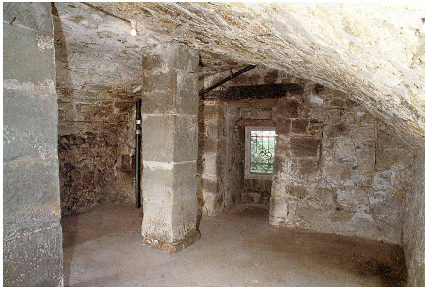
Abb. 10 Fribourg/Johanniterkomturei. Zweites Untergeschoss, Blick nach Nordwesten
