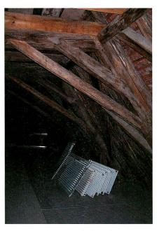
Fig. 7 Châtel-Saint-Denis/Château. Corps de logis central, charpente de 1830/1831 et les seconds aisseliers de 1831/1832
