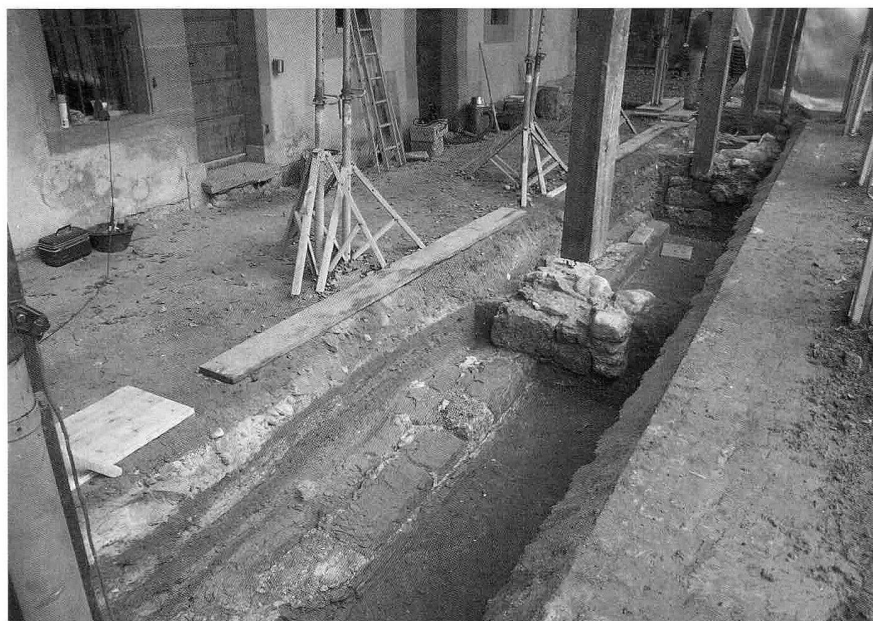
Fig. 10 Romont/Château. Fouille sous le portique, mur bahut de 1379/80
