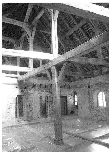
Fig. 8 Gruyères/Château. Charpente de l'ancienne conciergerie datant de 1563/64
