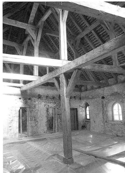
Fig. 8 Gruyères/Château. Charpente de l'ancienne conciergerie datant de 1563/64
