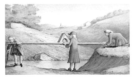
Fig. / Abb. 1 Nivellement d'un terrain au XVIII<sup>e</sup> siècle (tiré de Montesson 1766) Nivellieren eines Geländes im 18. Jahrhundert (aus Montesson
