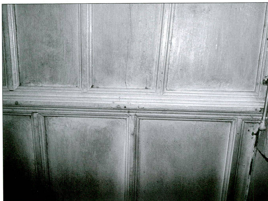
Fig. / Abb. 11 Deuxième étage, détail du plafond à couvre-joint (XVII e siècle) Zweites Stockwerk: Detail von der Decke mit Abdeckleisten (17. Jahr- hundert)
