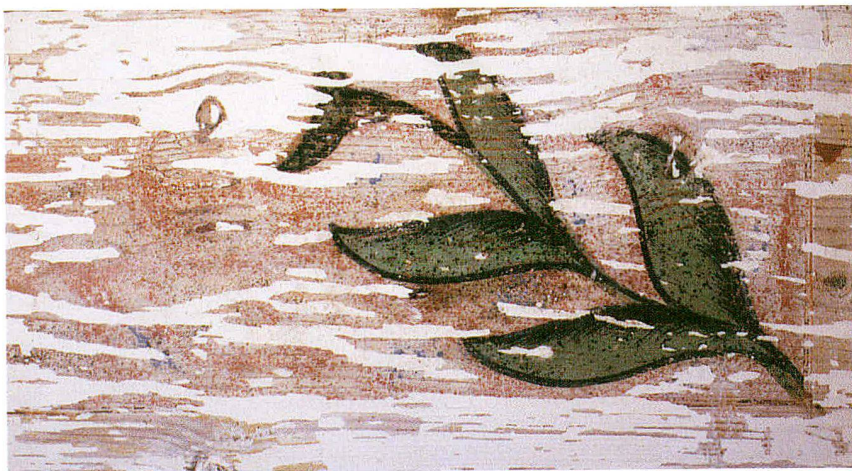
Abb. 9 Zweites Obergeschoss, Südseite, Decke von 1535/36 mit Malerereisten
