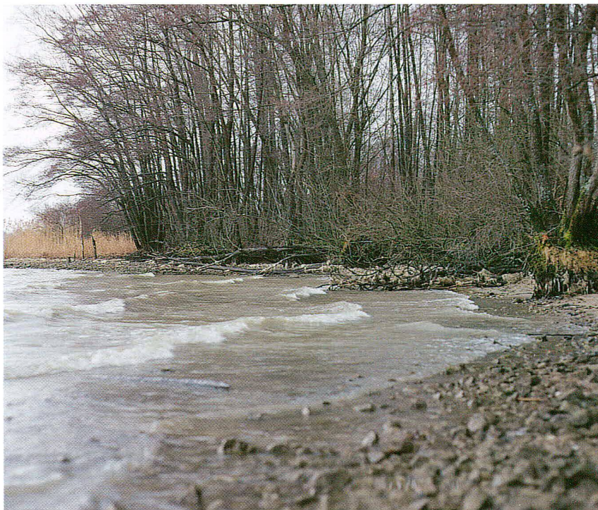
Fig. 11 Erosion de la rive sud du lac de Neuchâtel: site de Font/Sous l'Epenex avant sa protection
