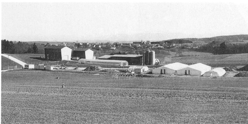
Fig. 11 Châbles/La Biolleyre 1. Vue générale du chantier depuis l'ouest; la nécropole de l'âge du Bronze se situe sous la grande tente
