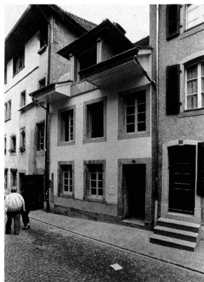
Abb. 71 (links) Murten/Kreuzgasse 11. Strassenseitige Fassade, Zustand während der Bauarbeiten
