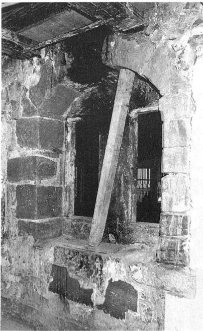
Fig. 28 Fribourg/R. de la Neuveville 1. L'encadrement interne des fenêtres doubles du début du XV e siècle
