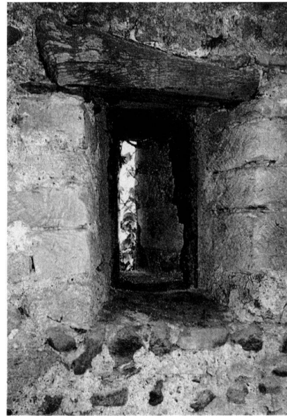
Abb. 78 Murten/Ringmauer. Inneres Gewände der östlichen Schiessscharte im ersten Geschoss des Pfaffenturmes
