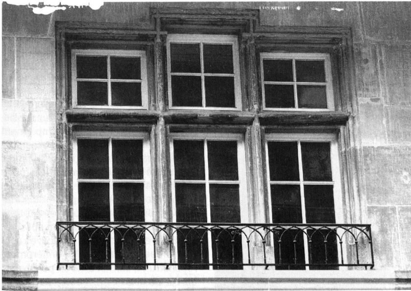
Fig. 31 Fribourg/R. de la Neuveville 1. Fenêtre en pyramide, à double croisée, du deuxième étage de la maison n° 1 (1612/1613)
