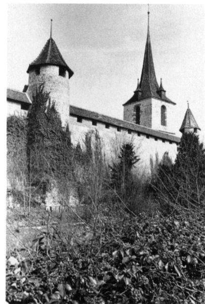
Abb. 75 Murten/Ringmauer. Ansicht der Ringmauer mit Pfaffenturm (im Vordergrund) und Katzenturm. Im Hintergrund der Turm der Deutschen Kirche
