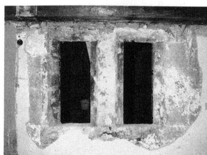
Fig. 26 Fribourg/R. de la Neuveville 1. Détail des fenêtres doubles du début du XV e siècle (?)
